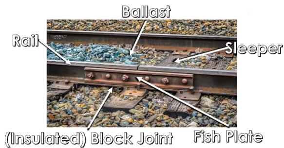
FIGURE 5: TYPICAL RAIL LAYOUT.
